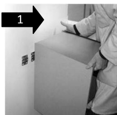
1 Accrocher le meuble sur les pattes Hang the unit onto the wall plates
