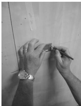
2 Positionner le gabarit, tracer et percer
