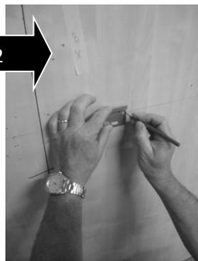
2 Positionner la patte, tracer et percer
