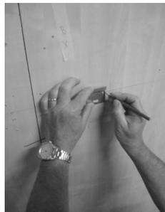
2 Positionner le gabarit, tracer et percer
