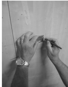
2 Positionner le gabarit, tracer et percer
