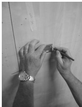
**2 Positionner le gabarit, tracer et percer**
