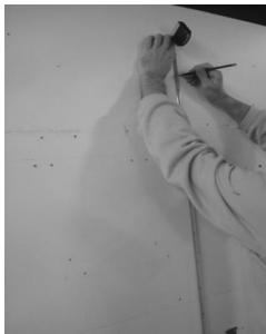
1 Déterminer la hauteur de pose finale
