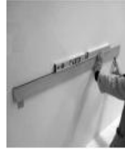
4 Placer la deuxième patte murale en l'alignant de niveau avec la première
