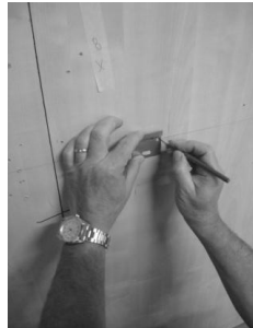
2 Positionner le gabarit, tracer et percer
