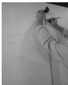
1 Déterminer la hauteur de pose finale
