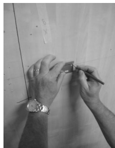
2 Positionner le gabarit, tracer et percer
