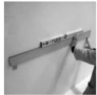
d-Placer la deuxième patte murale en l'alignant de niveau avec la première
