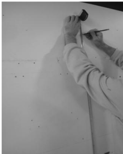
a-Déterminer la hauteur de la pose finale
