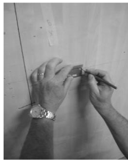
b-Positionner le gabarit, tracer et percer
