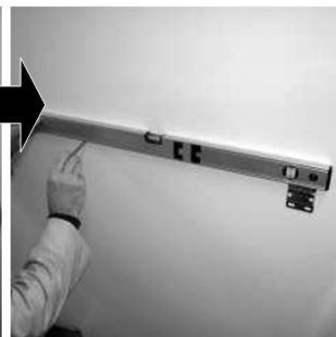
4 Placer la deuxième patte murale en l'alignant de niveau avec la première Place the second wall plate aligning it with the first one
