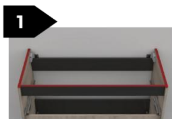
1-Appliquer le silicone sur le caisson et le mur.
