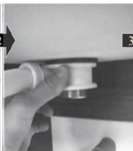
2- Raccorder le trop plein à la bonde
