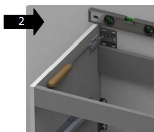
2 Serrer les accroche-meubles pour faire plaquer le meuble au mur et ajuster les niveaux Tighten the brackets on the unit so that the furniture fits to the wall and adjust the levels
