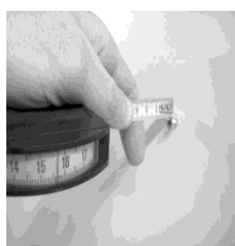
3. LA VIS DOIT DEPASSER DU MUR DE 8 MM MAXIMUM THE SCREW MUST PROTUDE MAXIMUM 8 MM FROM THE WALL
