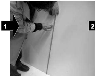
1 Déterminer la hauteur de pose finale
