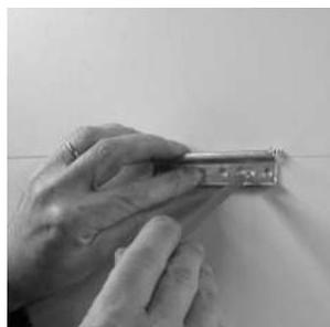
**2 Positionner la patte murale (voir schéma), tracer et percer**
