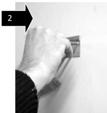
**2 Positionner la patte, tracer et percer**
