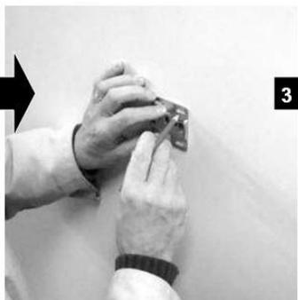
**2 Positionner le gabarit, tracer et percer**
