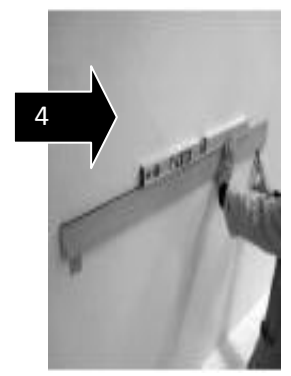
4 Placer la deuxième patte murale en l'alignant de niveau avec la première
