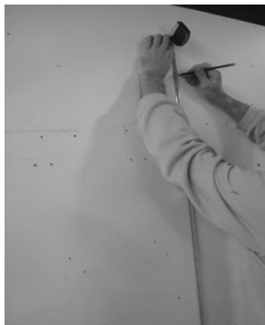
1 Déterminer la hauteur de pose finale Determine the finished height
