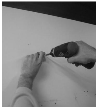
3 Fixer la première patte Fix the first wall plate
