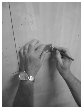
2 Positionner le gabarit, tracer et percer Position the plate, mark and drill
